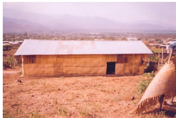
Evangelistkassan för Etiopien har bekostat plåttaket på den nya kyrkan i Arbaminch. Ingen lyx precis, men en plats för de kristna att mötas.
